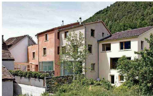
Wohnhäuser «Im Winggel» , Haldenstein. Norbert Mathis, Chur. (FOTO RALPH FEINER)
