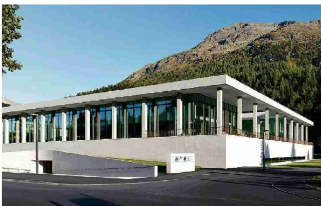
... das Ovaverva-Hallenbad in St. Moritz ... Bild Ralph Feiner
