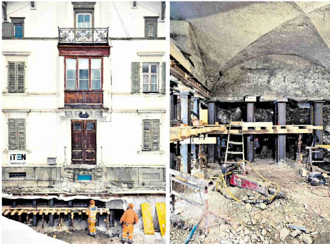
Das Kellergewölbe der Weissen Villa in Mulegns wird für die Verschiebeaktion vorbereitet.
