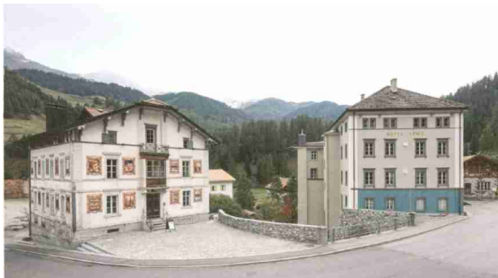
Die Verschlebung der direkt neben dem Post Hotel Löwen gelegenen Weissen Villa schuf die Grundlage für die Neustrukturierung und gewährt seitdem der Jülierstrasse mehr Fläche.
