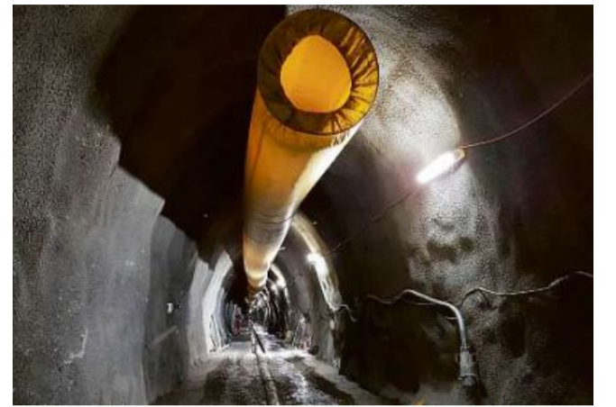
Perfurada da drenascha davent dalla galareia da sondascha ainten la massa sglischonta.
