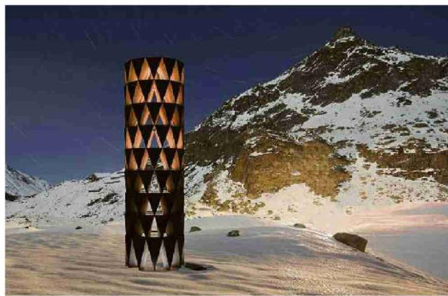
Origenes neuste Idee: ein bleibendes Kulturhaus auf der Julierpasshöhe in Form eines 55 Meter hohen Zylinders mit neun Geschossen, aus lauter spitzwinkligen Dreiecken zusammengefügt. (FOTO ZVG)
